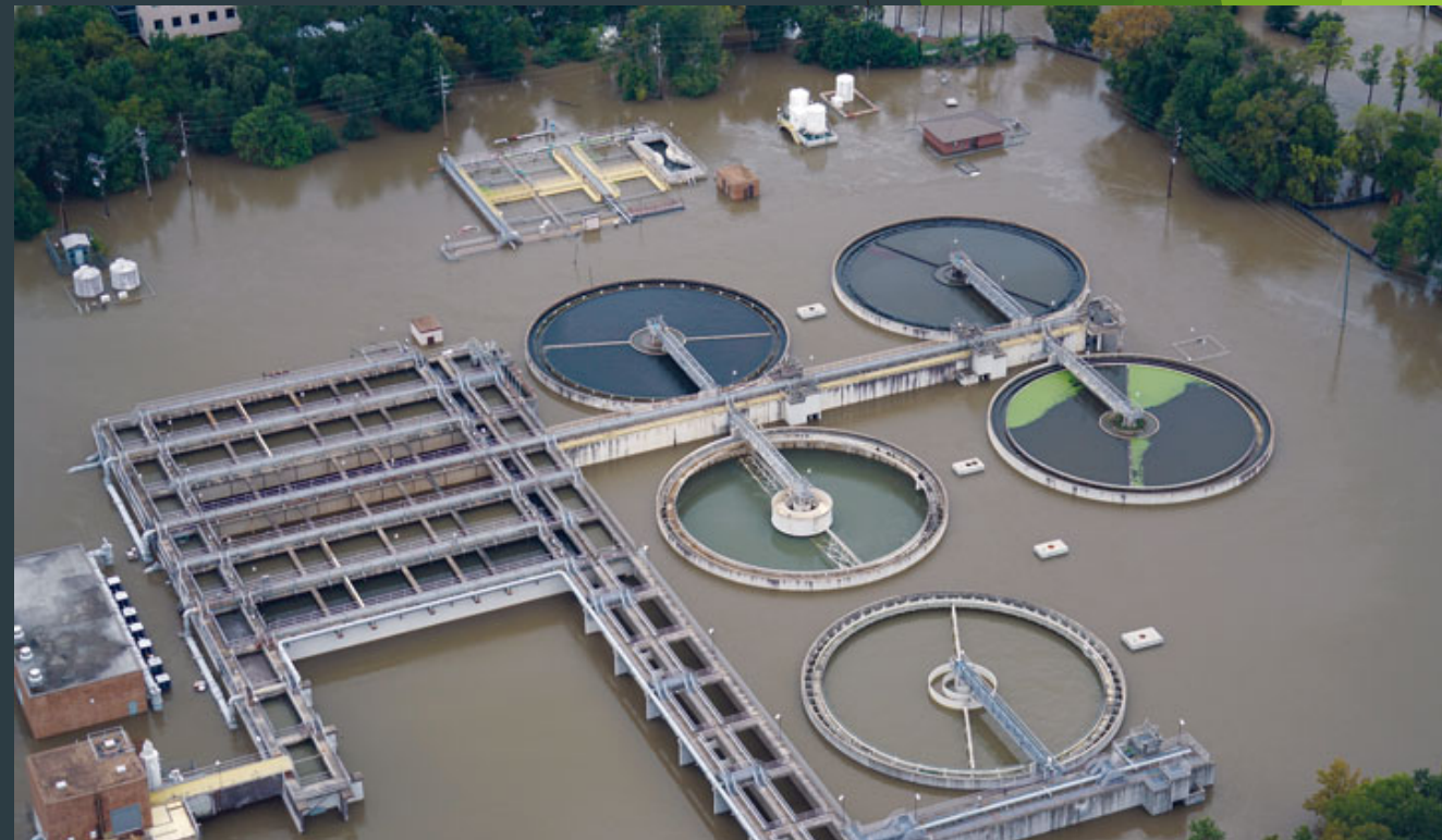
Ολική καταστροφή (πλημμύρα) εγκατάστασης από τον τυφώνα Χάρβεη (Τέξας 2017)
