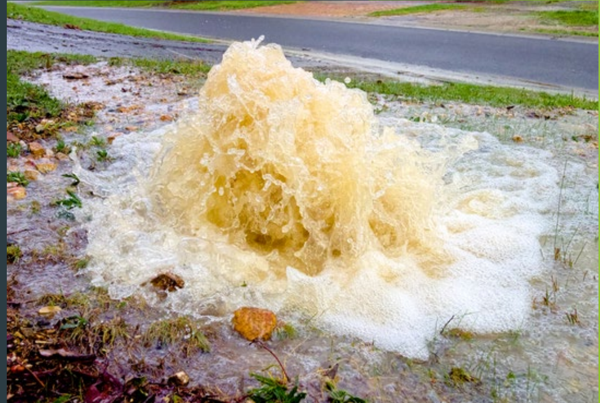
Διαρροή λυμάτων στην επιφάνεια του φυσικού εδάφους ύστερα από αστοχία σωληνώσεων (Ντάλλας 2009)
